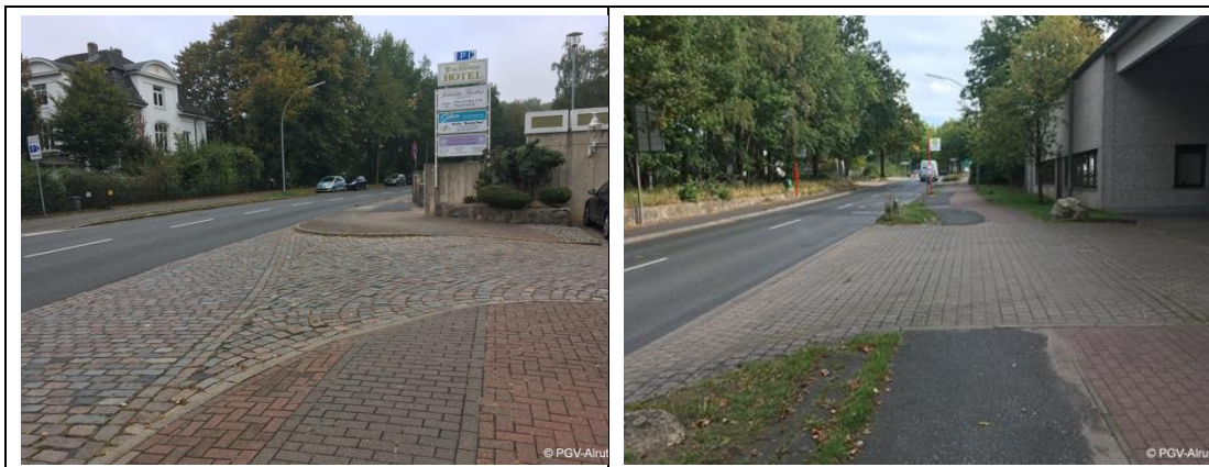
Abb. 3-3: Fehlende Furt und unzureichende Belagsqualität im Zuge der Hamburger Straße (L 223, links), Unterbrechung des Radweges an Grundstückszufahrt im Zuge Hermann-Körner-Straße (rechts)
