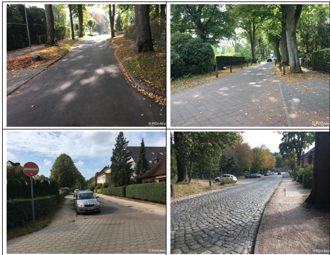
Abb. 3-4: Mischverkehr im Zuge Schillerstraße (oben links) und Kückallee (oben rechts); Lindenstraße ohne Freigabe für Radverkehr in Gegenrichtung und unzureichende Belagsqualität (unten links); Parkallee mit unzureichender Belagsqualität (unten rechts).
