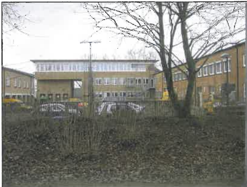
Abbildung 6 Betriebsgebäude mit neuem Erweiterungsbau
