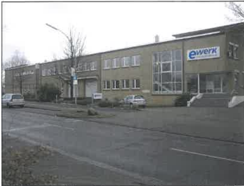
Abbildung 5 Betriebsgebäude an der Hermann-Kömer-Straße
